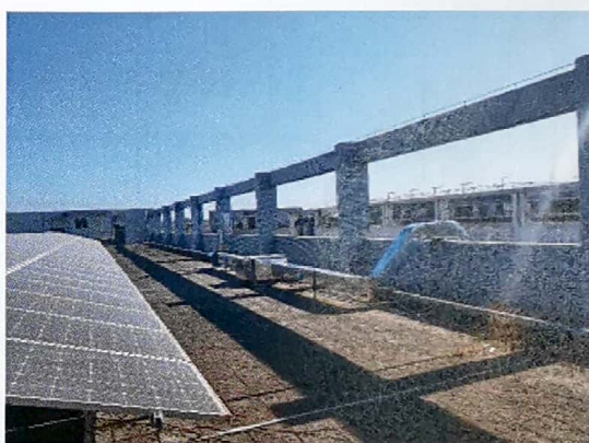
废气处理设施
