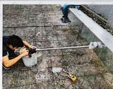
注塑废气排放处理后检测口
