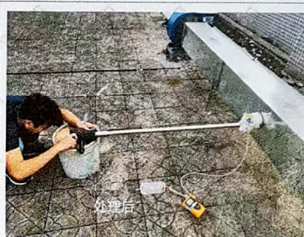
注塑废气排放处理后检测口
