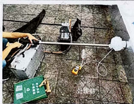
注塑废气排放处理前检测口
